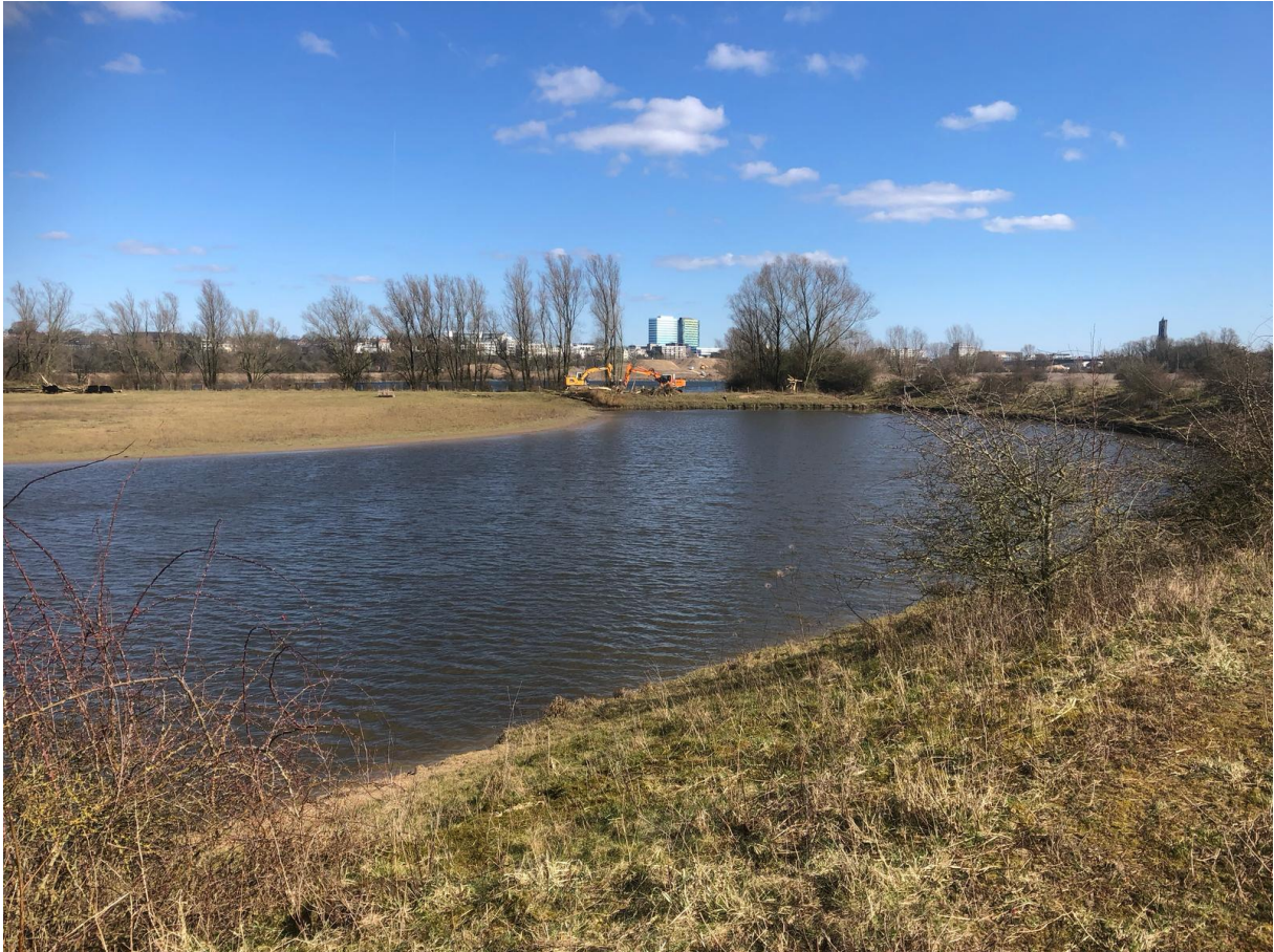
Fig werkzaamheden bij de dam op 21 maart, bomen gekapt en geul uitgegraven.
