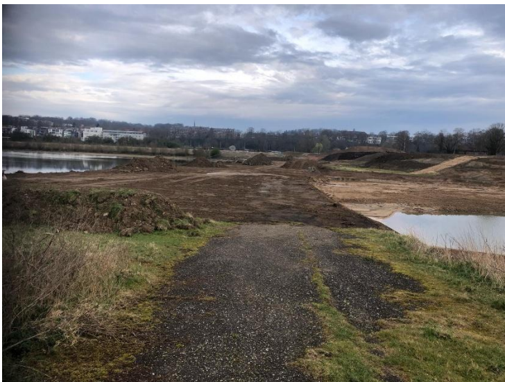
Fig de dam bovenstrooms van de plas is nog dicht op 23 maart, het grondwerk gaat beginnen
